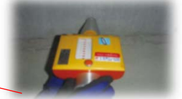
基礎コンクリートの強度検査
