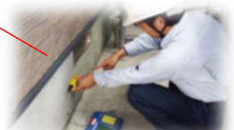
基礎内部の鉄筋検査
