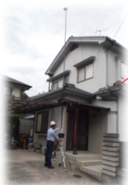
ポールカメラによる屋根検査
