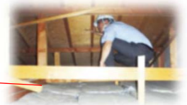
小屋裏の検査
