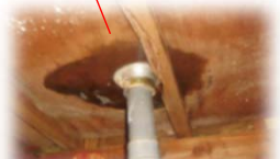
床下配管の漏水チェック
